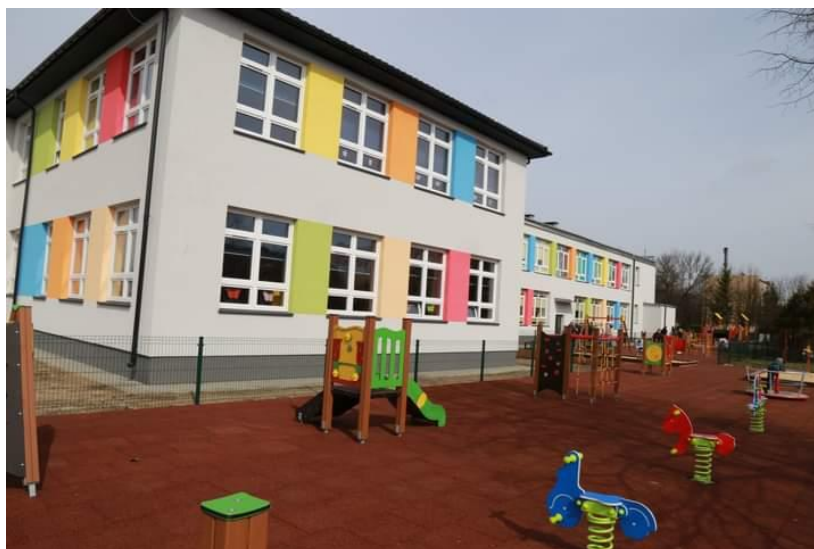
Budynek Przedszkola po rozbudowie, obok plac zabaw
