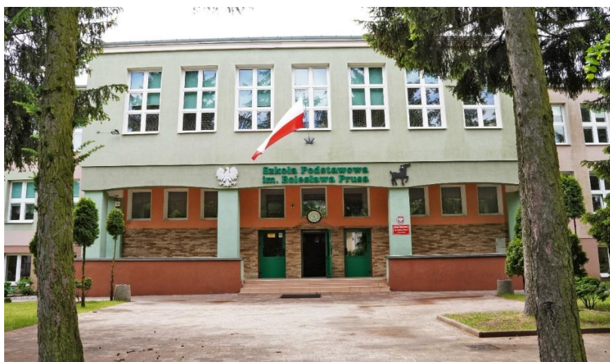
Wejście główne od ul. Pocztovej
