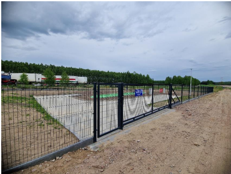
Budowa kanalizacji w Leonowie
